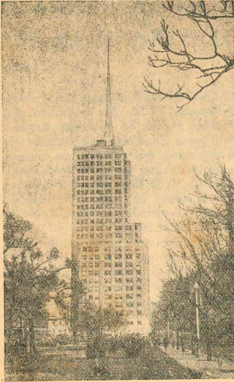
Vista de la magnífica antena de televisión instalada en el edificio del Ministerio de Obras Públicas de la ciudad de Buenos Aires.
