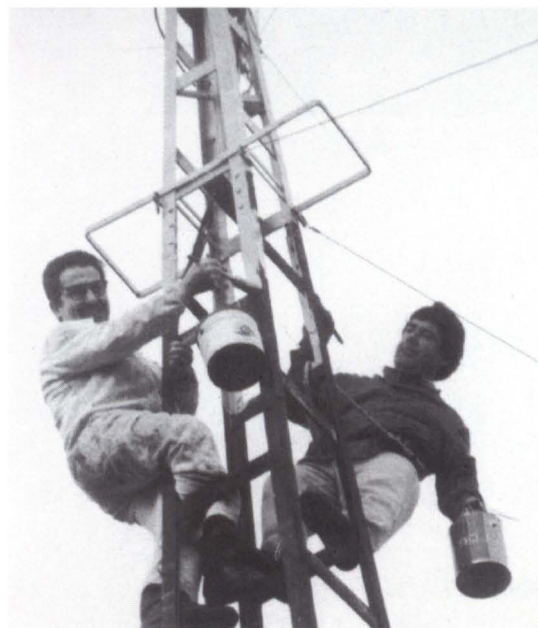
EA3GJW y EB3API pintando la torre del repetidor EA3F
