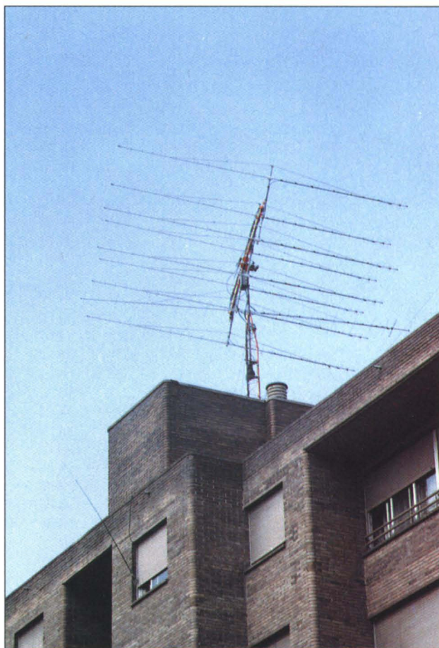
Foto 12: 8 antenas X 31 elementos para 432 MHz. Instalación de EA2LU para Rebote Lunar.
