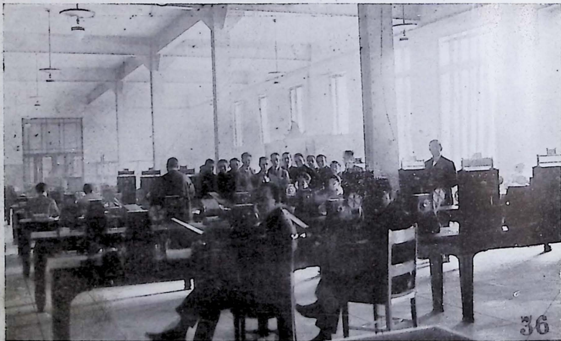
36. Vista parcial de la sección de Baudots.
