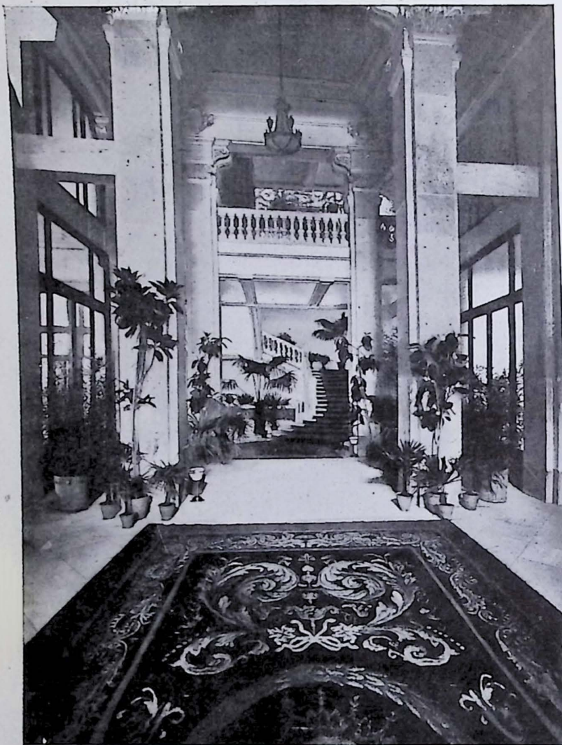
Interior del Palacio de Comunicaciones. Escalera principal de la Dirección general de Telégrafos.
