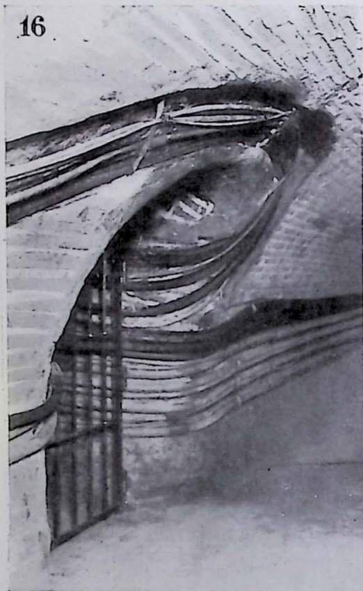
16 y 17. Entrada subterránea de cables en la galería del canal de Isabel II y su enlace con los del Palacio de Comunicaciones.
