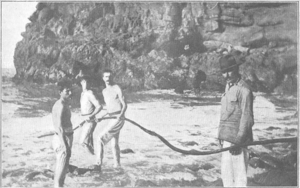
Reparación del cable Tenerife-La Palma. En el centro del grabado puede observarse la avería.
