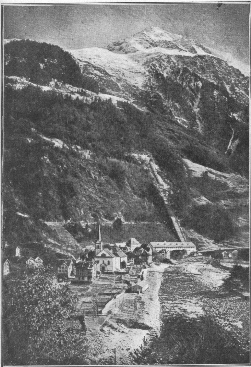
Vista del pueblo de Am:teg y la canalización del salto que proporciona la energía hidráulica para la línea del San Gotardo.
