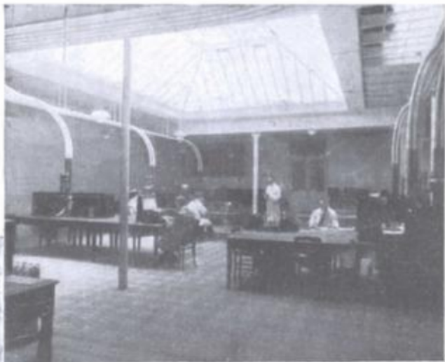
Sala de recepción y transmisión en la central.
