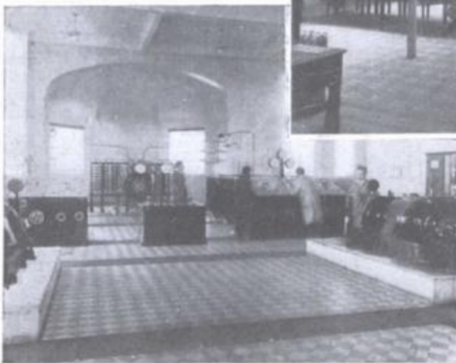
Estación radioeléctrica continental en Sainte-Assise.
