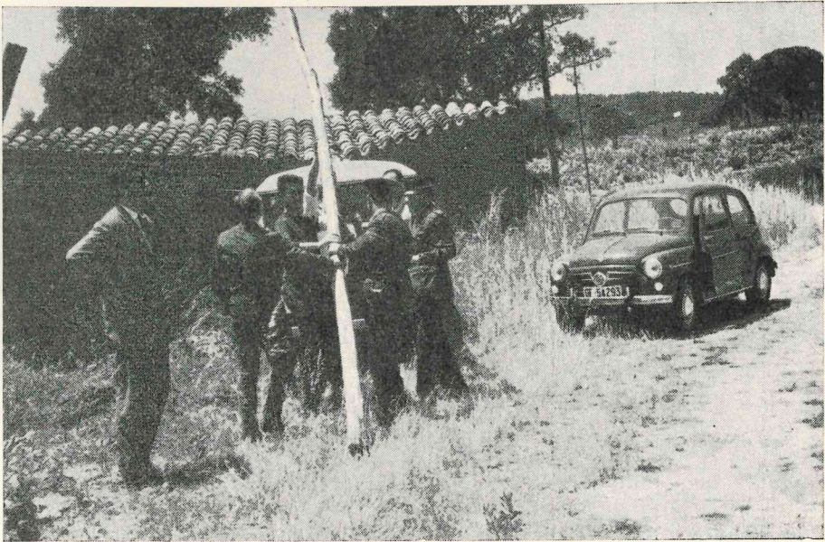
Izado del poste para la antena. Todos colaboran en el esfuerzo.
