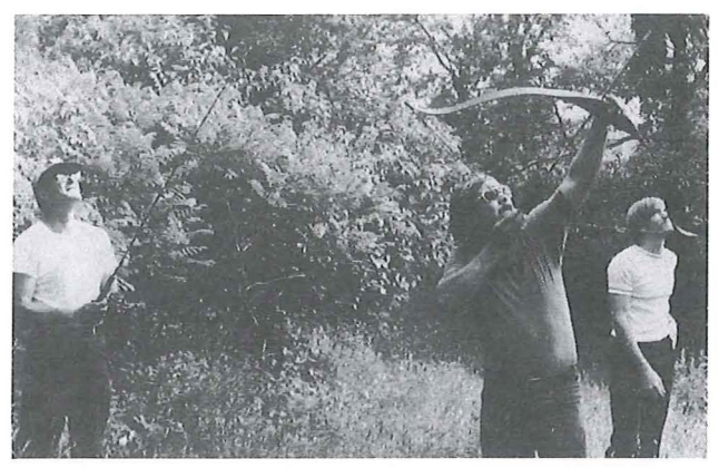
Fig. 72 – Existen muchas formas de colocar una cuerda en un árbol que soporte una antena. Estos aficionados utilizan un arco con una flecha, que arrastra un hilo fino de nilón, para hacerlo pasar por encima de la rama deseada. Entonces, atan la cuerda soporte al sedal y, tirando del último, hacen pasar la cuerda sobre la rama.
