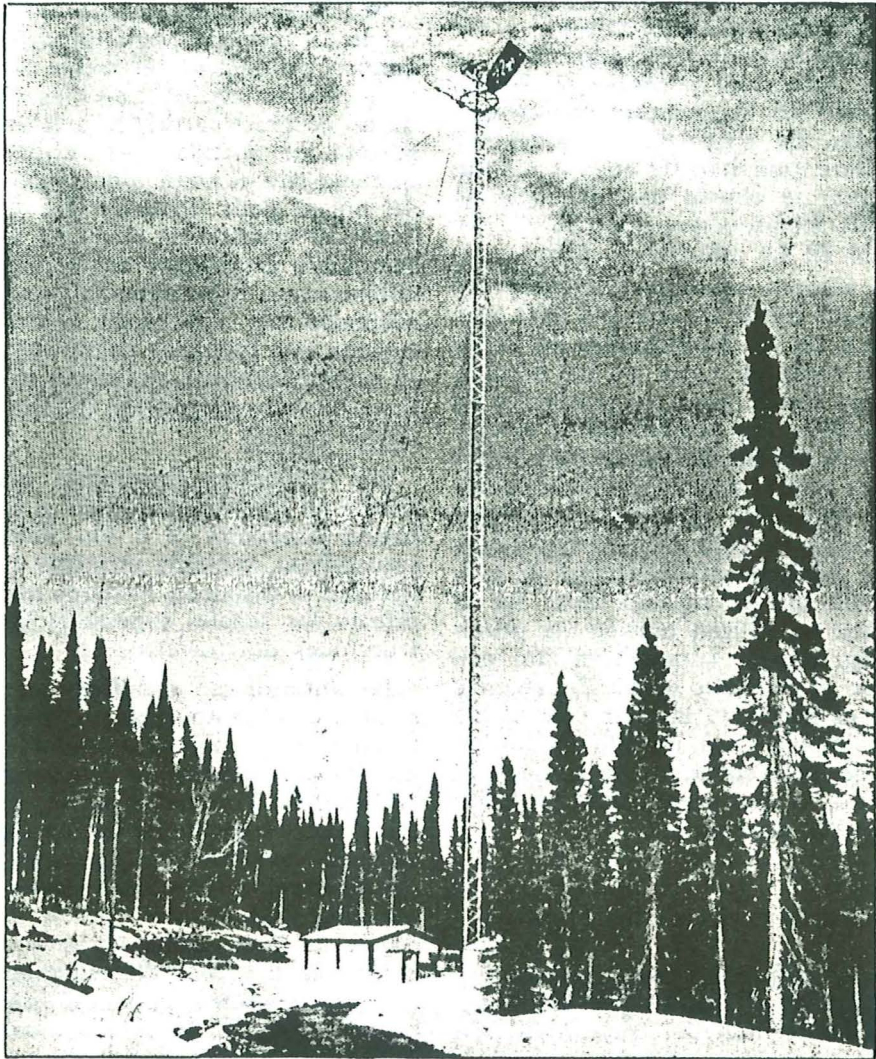
FIG. 11.—Antena periscópica compuesta de un radiador parabólico colocado a nivel de tierra, unido al equipo de microondas con una corta guía de ondas, y un reflector pasivo instalado arriba de la torre. Este sistema suministra la altura libre del trayecto sin el coste elevado ni los inconvenientes de transmisión que presentaría una larga guía de ondas desde el equipo hasta la cima de la torre.
